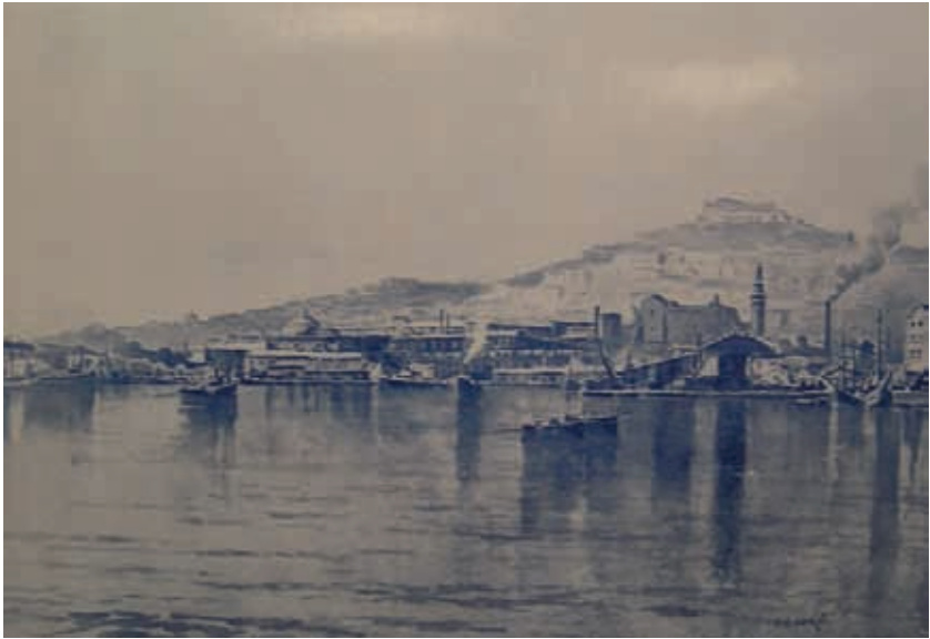
Com'è - Veduta dall'interno del Porto
